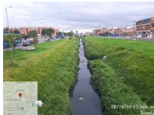
Canal Tintal I -*Tramo 2 y 3
