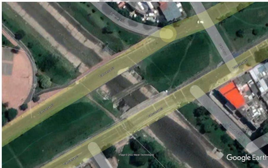
Ilustración 16. Puente del corredor férreo existente sobre el Rio Fucha. Fuente propia.
