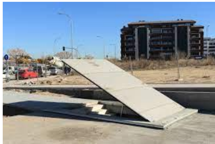
Figura 98. Salida en superficie de salidas de emergencia
