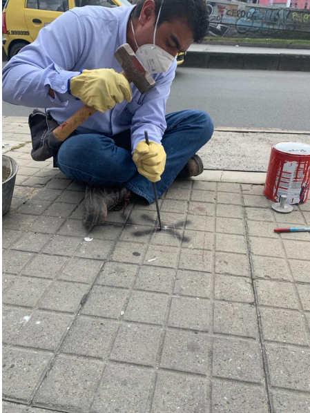
Figura 9. Ubicación y demarcación preliminar (scouting) Fuente: Unión Temporal Extensión Metro Línea 1
