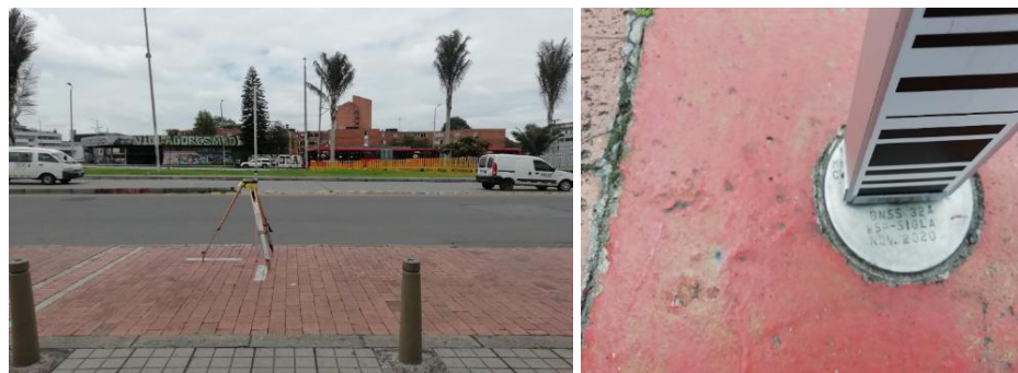
Figura 38. Nivelación GNSS32A Fuente: Unión Temporal Extensión Metro Línea 1
