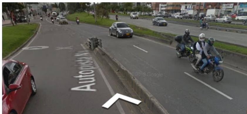
Figura 6. Segregación calzada lateral en dos calzadas
