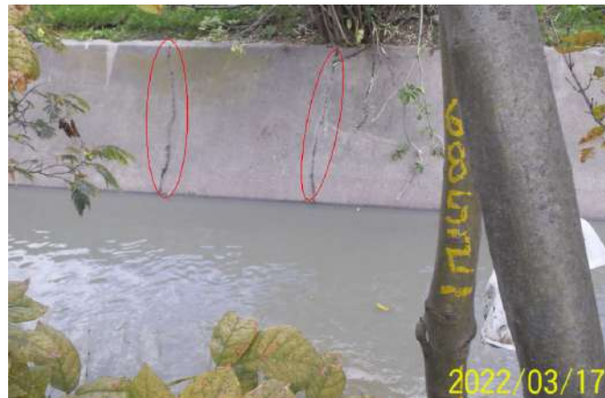
Figura 102. Box culvert estación Virrey costado occidental, fisuras en las placas laterales del canal
