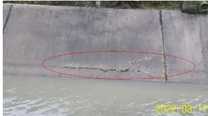
Figura 103. Box culvert estación Virrey costado occidental, fisuras en las placas laterales del canal
