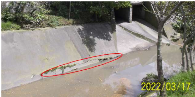
Figura 99. Box culvert estación Virrey costado occidental, fisuras en las placas laterales del canal
