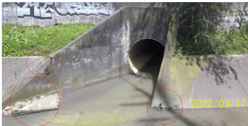
Figura 99. Box culvert estación Virrey costado occidental, fisuras en las placas laterales del canal
