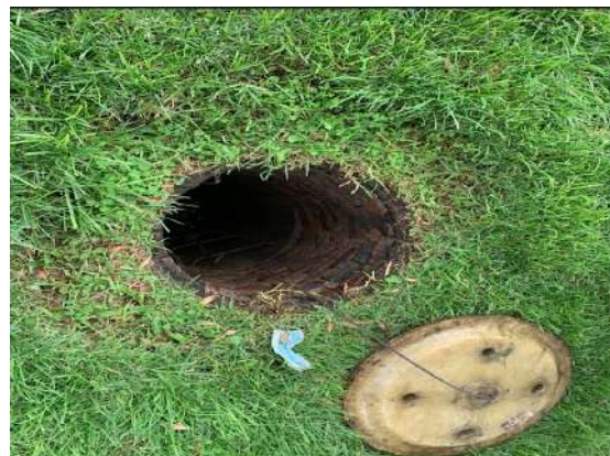
Fotografía 1. Purga y Pozo de drenaje Línea Tibitoc K21+104
