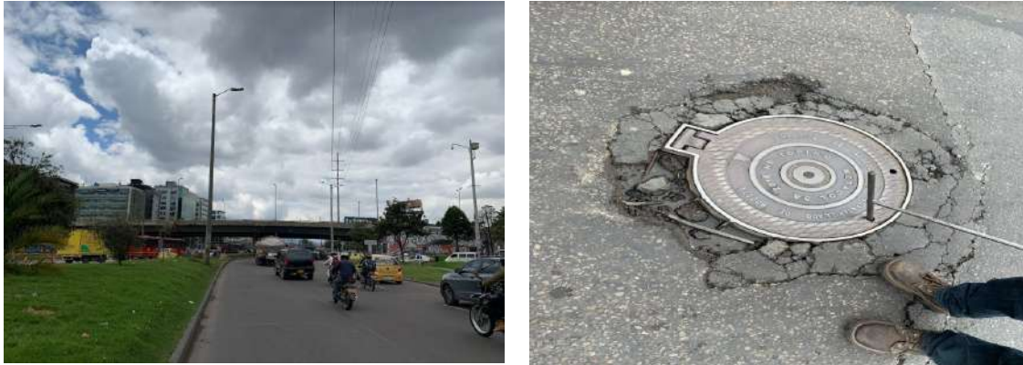
Fotografía 6. Boca de acceso Línea Tibitoc K26+157
