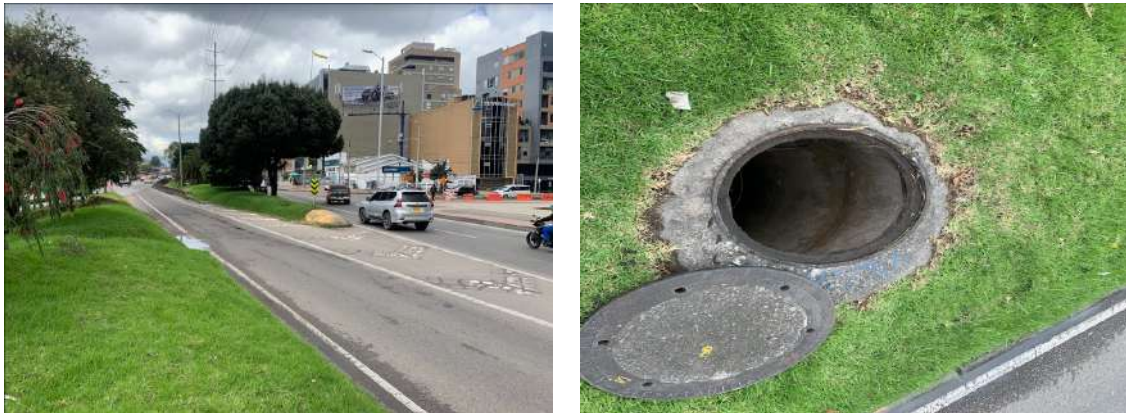
Fotografía 2. Boca de acceso Línea Tibitoc K27+051
