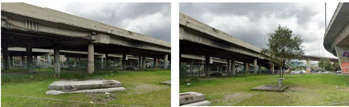
Fotografía 11. Unión Línea Tibitoc Refuerzo Calle 128- Calle 92 y Línea Tibitoc Santa Lucía
