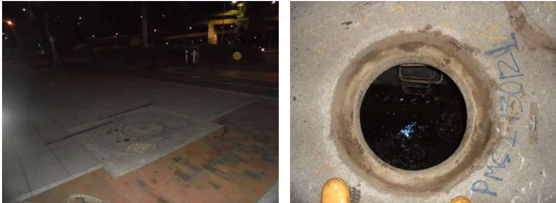
Figura 25. Box Culvert La Castellana Accesos
