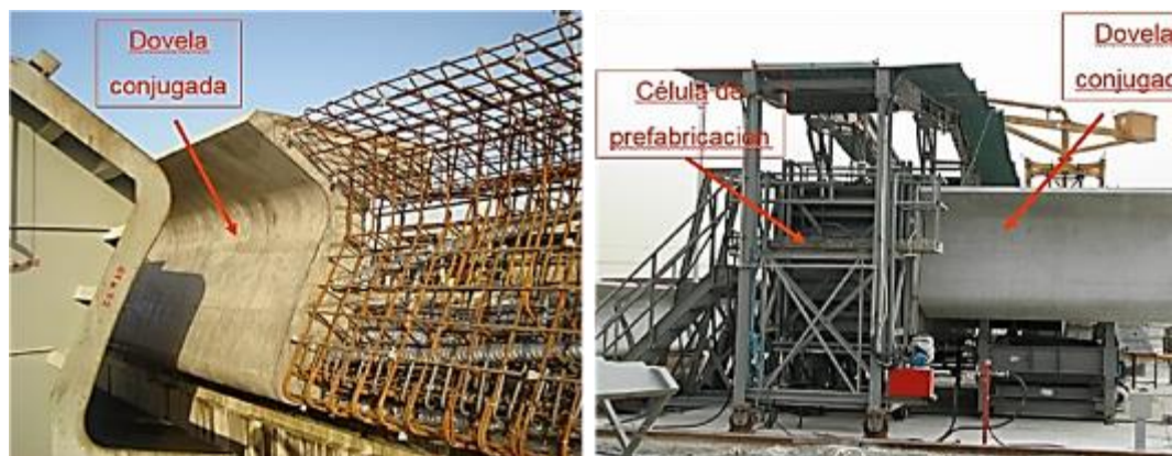
Figura 335. Célula de prefabricación de dovela estándar Fuente: UT MOVIUS 2022
