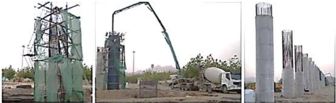
Figura 326. Construcción de fustes de pila para viaducto de metro
