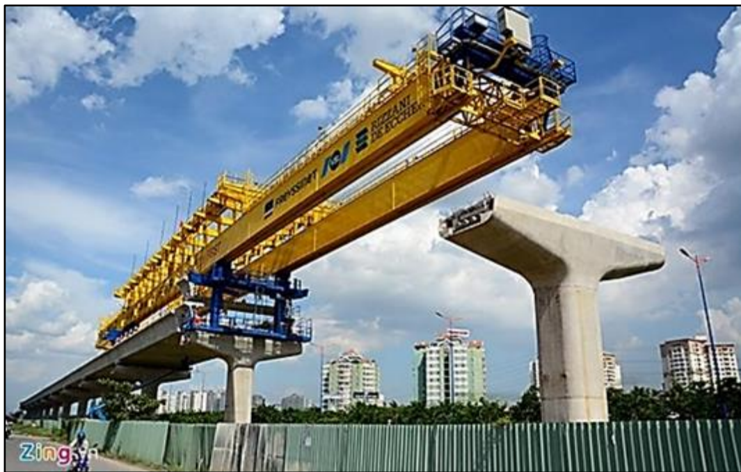
Figura 331. Montaje del tablero gran U del metro de Ho Chi Minh mediante viga lanzadora Fuente: UT MOVIUS 2022
