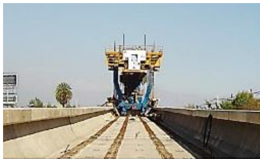
Figura 350. Carro de apoyo de la viga lanzadora y sistema de avance sobre tablero
