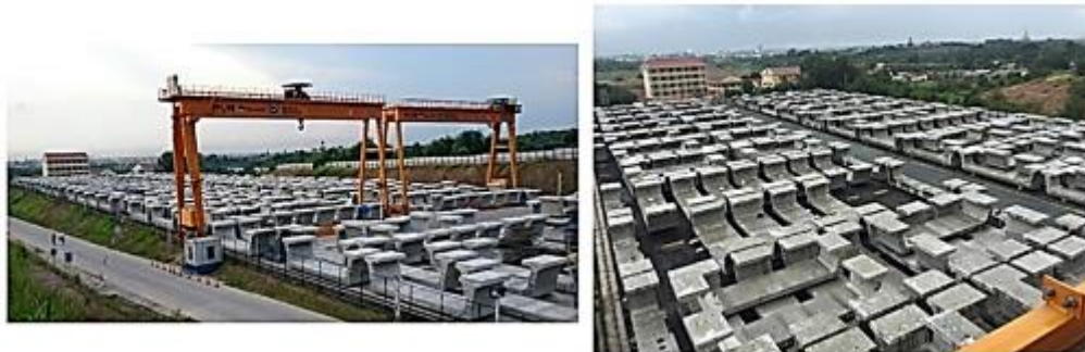
Figura 336. Áreas de acopio de dovelas en parques de prefabricación
