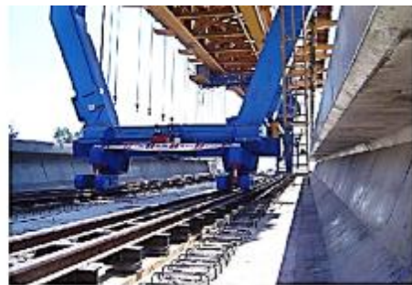
Figura 350. Carro de apoyo de la viga lanzadora y sistema de avance sobre tablero
