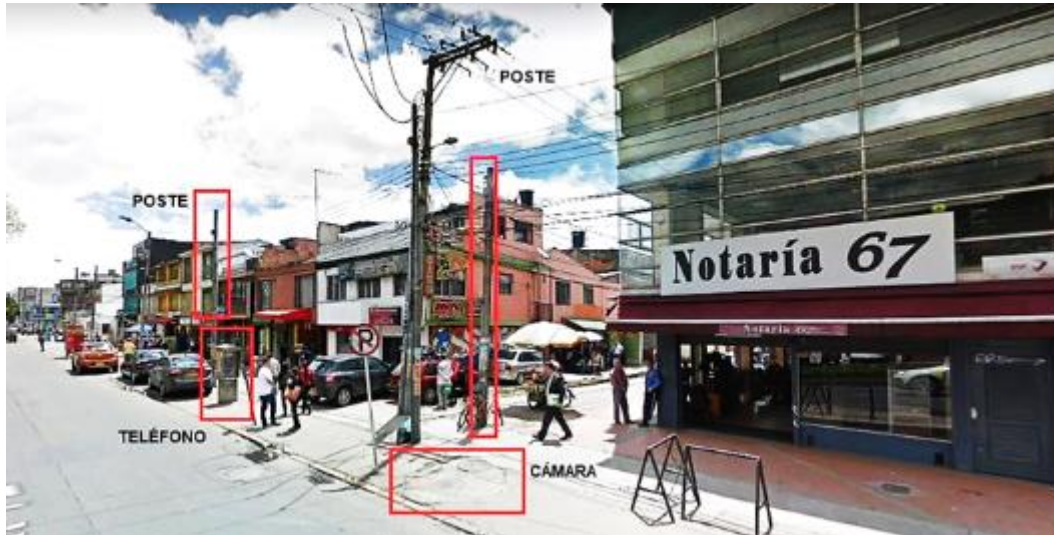
Fotografía 14. Redes de ETB sobre la Calle 72. Fuente: Google Earth
