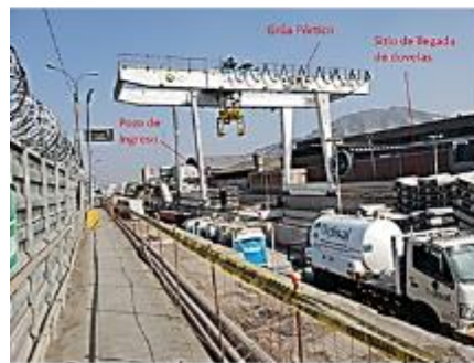
c. Puente grúa y zona de manipulación de dovelas
