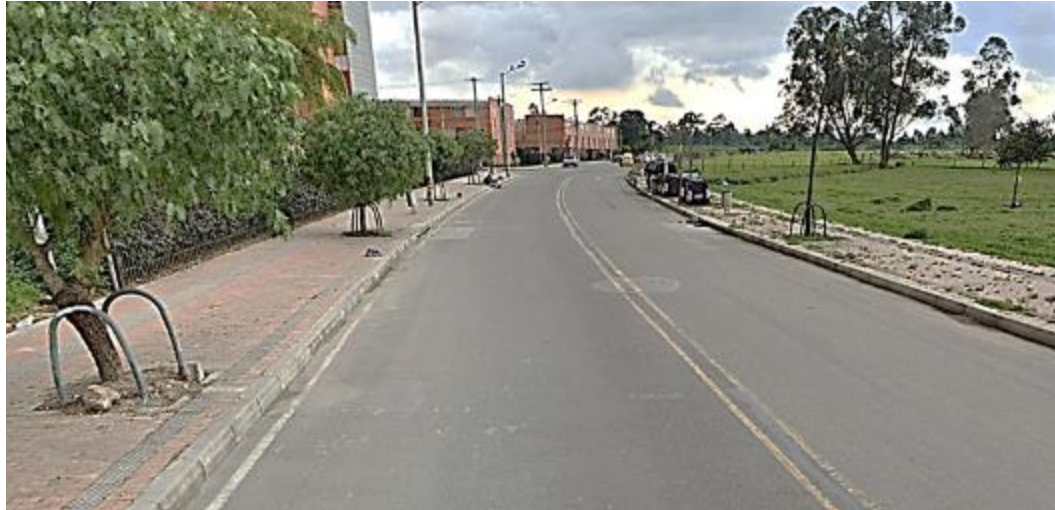
Fotografía 6. Situación actual diagonal 151
