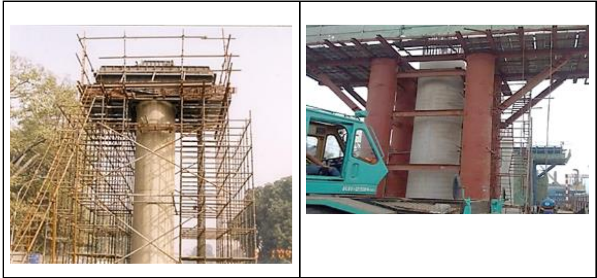
Figura 327. Construcción de capitel colado in situ sobre cimbra apoyada en el suelo Fuente: UT MOVIUS 2022
