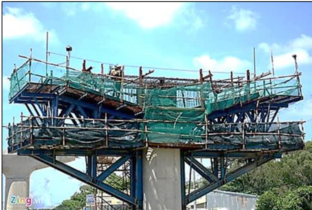
Figura 328. Capitel colado in situ sobre cimbra soportada por brackets (metro de Ho Chi Minh) Fuente: UT MOVIUS 2022
