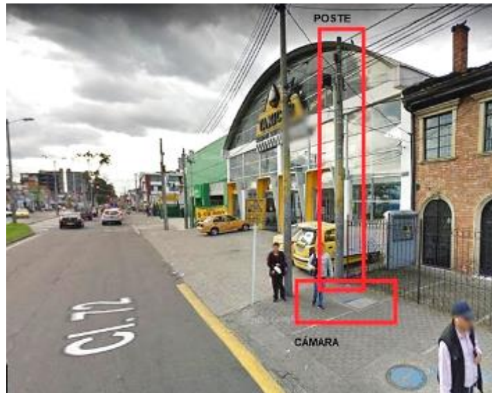
Fotografía 16. Redes de MOVISTAR sobre la Calle 72 Fuente: Google Earth
