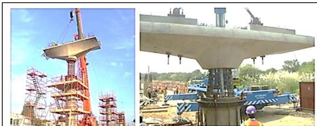
Figura 329. Instalación de capitel prefabricado sobre anillo de posicionamiento Fuente: UT MOVIUS 2022
