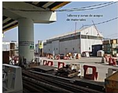
a. Talleres y zona de acopio
