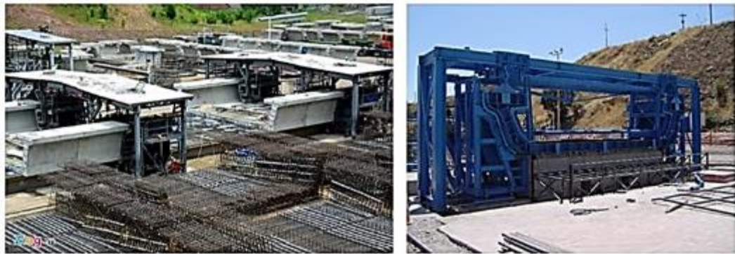
Figura 333. Banco corto y molde para dovela de pila Fuente: UT MOVIUS 2022
