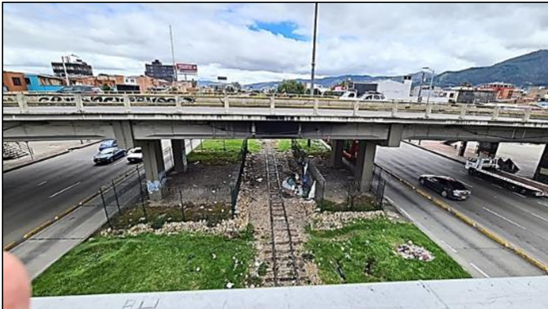
Fotografía 1. Línea férrea perteneciente al Ferrocarril del Norte cruzada perpendicularmente por el túnel del proyecto a la altura de la calle 72 con Av. NQS
