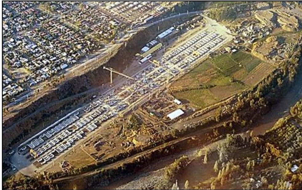
Figura 337. Vista aérea de parque de prefabricación para L4 de Metro de Santiago de Chile Fuente:UT MOVIUS 2022
