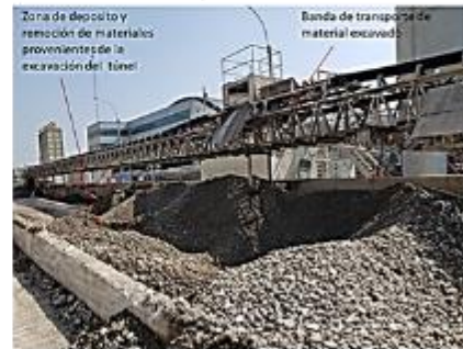
d. Zona de depósito de llegada de material del túnel – Banda transportadora
