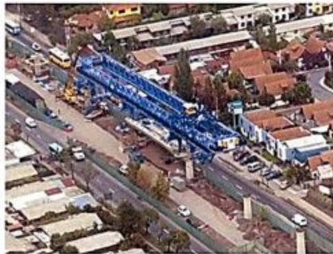
Figura 351. Avance de la viga lanzadora a vano siguiente
