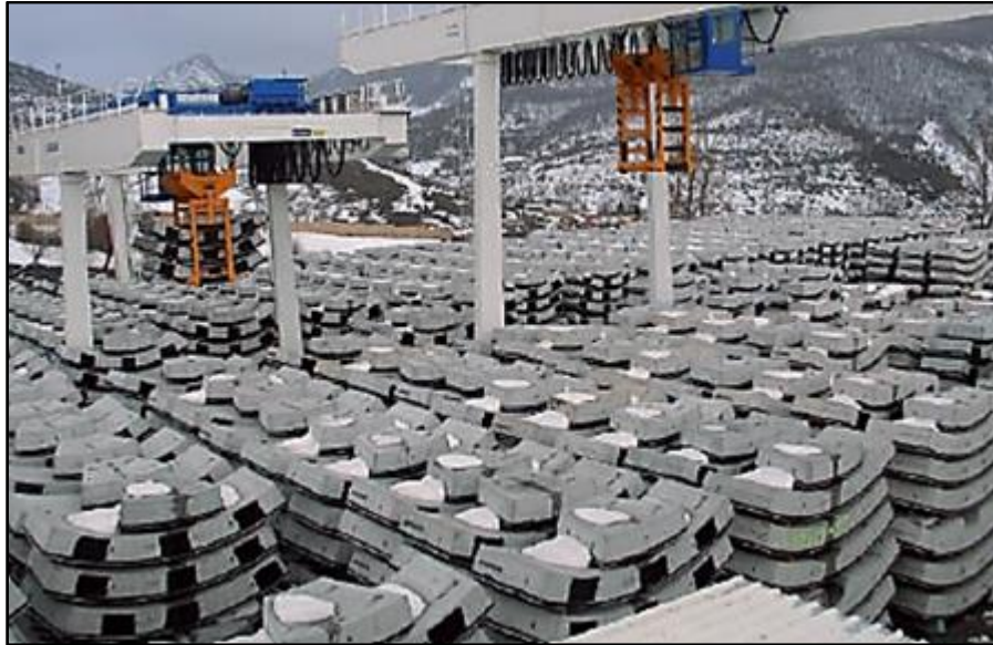
Fotografía 22. Sitio típico de acopio de dovelas prefabricadas Fuente: UT MOVIUS 2022
