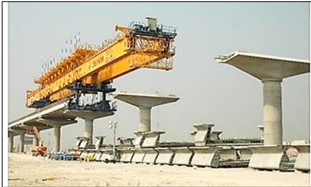
Figura 340. Acopio de dovelas bajo viaducto Fuente: UT MOVIUS 2022
