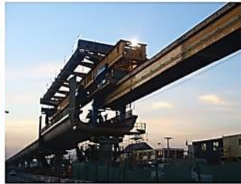
Figura 351. Avance de la viga lanzadora a vano siguiente
