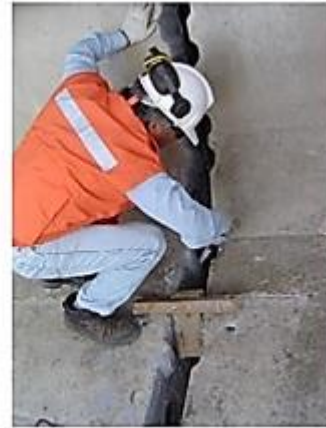
Figura 349. Ensamblaje temporal de dovelas mediante barras de pre esforzado y aplicación de adhesivo epóxico
