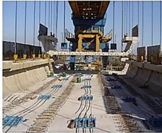
Figura 349. Ensamblaje temporal de dovelas mediante barras de pre esforzado y aplicación de adhesivo epóxico
