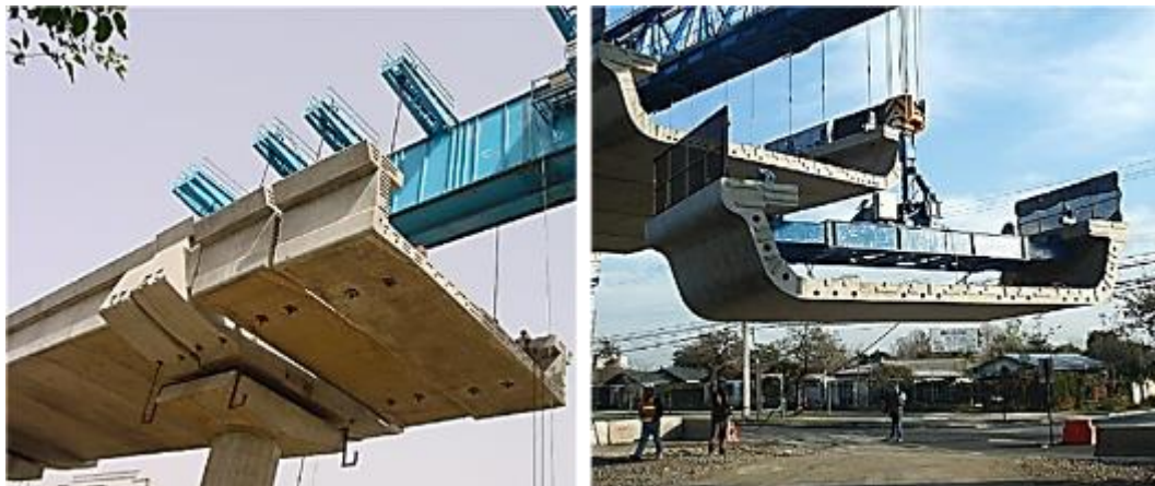
Figura 348. Izado de dovelas mediante viga lanzadora
