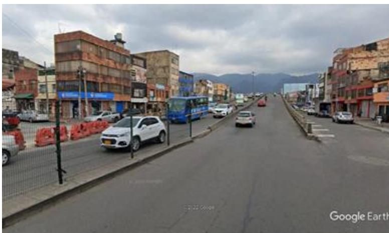
Fotografía 45. Puente Av. Chile sobre Av. Carrera 68. Sentido Occidente-Oriente Fuente: Imagen Google earth. Tomada el 2/10/21. Consultado el 19 de abril de 2022.
