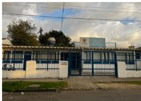
Fotografía 7. Unidad de Servicios de Salud Lorencita Villegas de Santos. Adscrito a Hospital de Chapinero Fuente: UT MOVIUS, 2022
