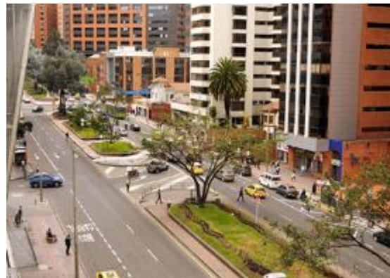
Fotografía 12. Estado de vía arterial Chapinero Fuente: DADEP, 2019.
