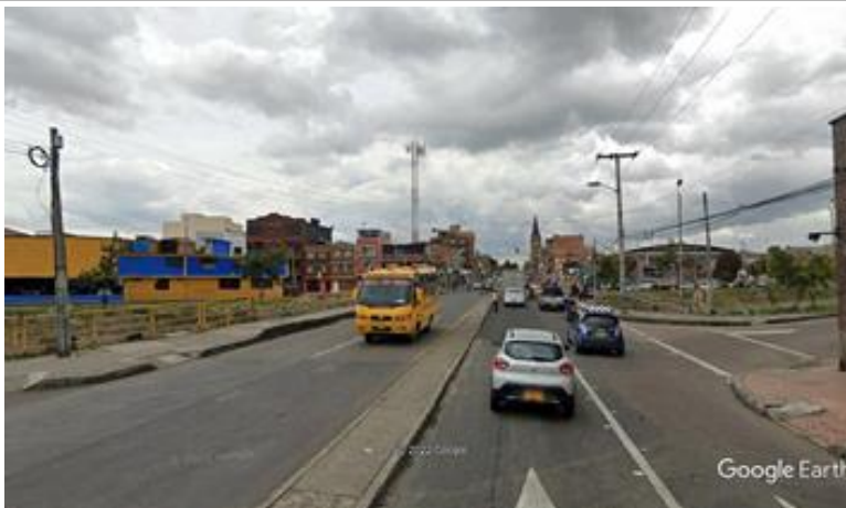
Fotografía 44. Puente Av. Chile con Tv. 56A
