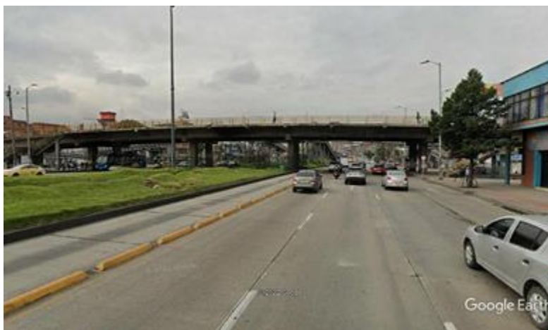
Fotografía 43. Puente Av. Chile sobre Av. Ciudad de Quito. Vista en sentido Norte-Sur
