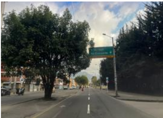
Fotografía 11. Malla vial Barrios Unidos Fuente: UT Movius, 2022
