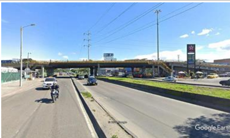
Fotografía 46. Puente AV. Chile con Av. Carrera 68. Vista en sentido Sur-Norte Fuente:Imagen Google earth. Tomada el 2/10/21. Consultado el 19 de abril de 2022.
