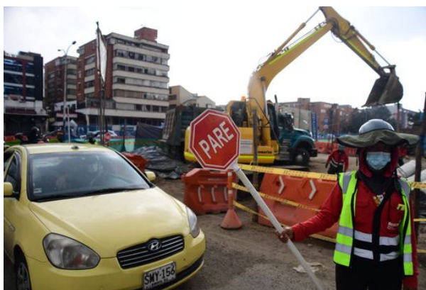
Figura 43. Obras en la Avenida 68 Fuente: El Espectador, 2022 16
