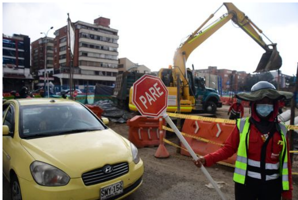
Figura 26. Obras en la Avenida 68 Fuente: El Espectador, 2022 4
