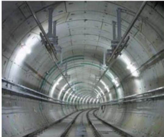
Figura 86. 1500 V con catenaria rígida en túnel
