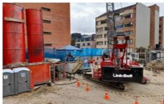
Figura 15 Señalización y demarcación de áreas
