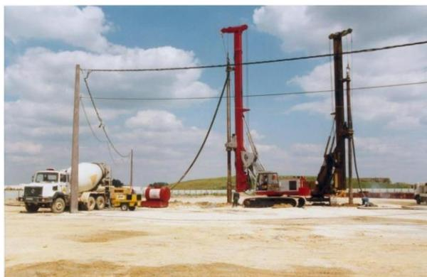
Figura 12 Vaciado de Concreto
