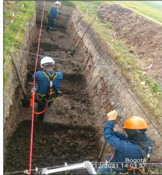
Fotografía 21 Excavación de trincheras
