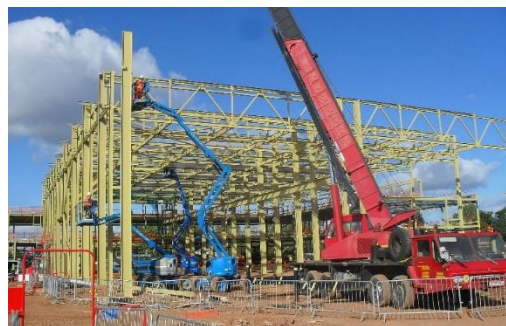
Instalación de cerchas, Figura, 2 (MTC INGENIERIA, 2022)
