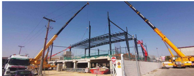
Instalación de cubierta, figura 3 (Espagruas, 2022; Espagruas, 2022)
