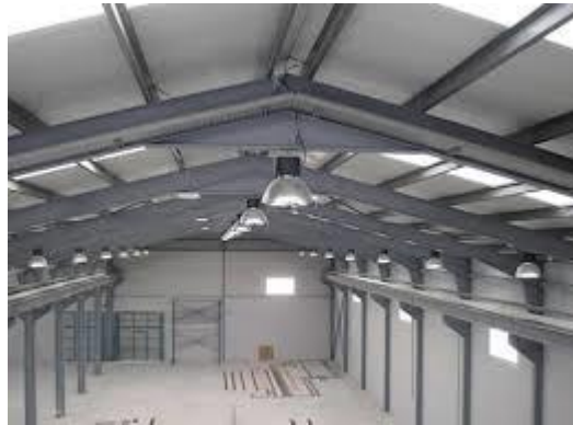
Montaje eléctrico e hidráulico, Figura 4 (Electricidad Ruiz felipe, 2022)
