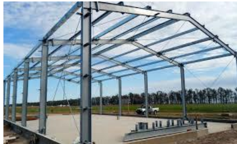
MONTAJE DE COLUMNAS Y VIGAS FIGURA 1 (METALICAS, 2022)
