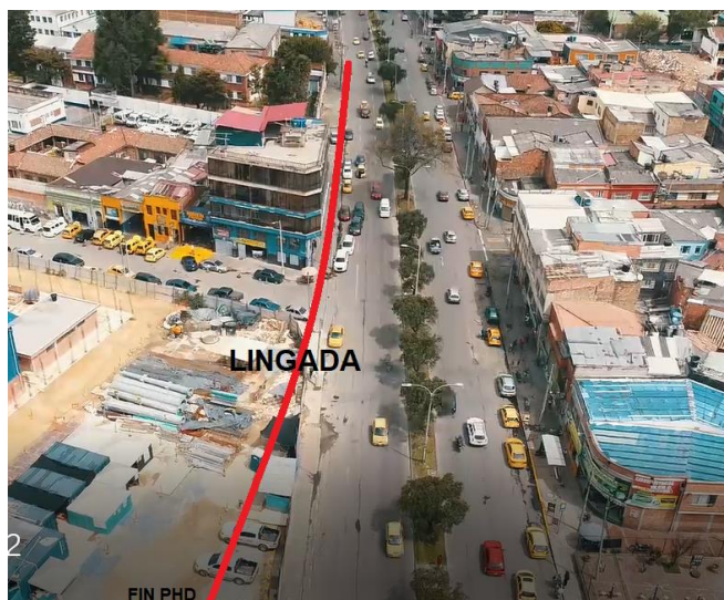
Figura 10 Vista aérea Fin Cruce No 1-SER-2 y ubicación de la lingada
