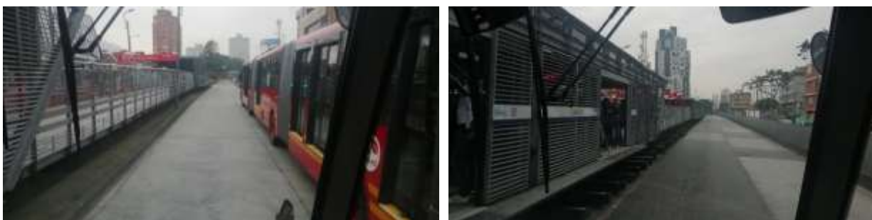
Fotografía 41 Troncal de la Avenida Caracas – Transmilenio
