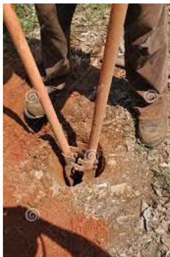
Fotografía 5 Excavación para instalación de postes
