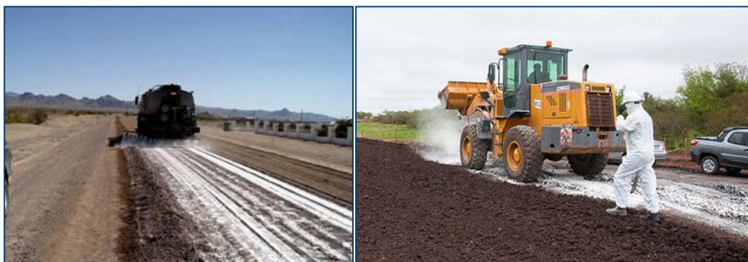
Fotografía 11 Procedimiento ilustrativo de mezcla del material existente con Cal
