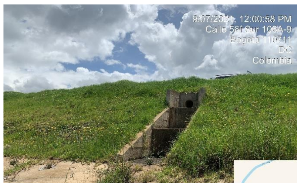
Fotografía 3 Sistema de Drenaje existente – Patio Taller
