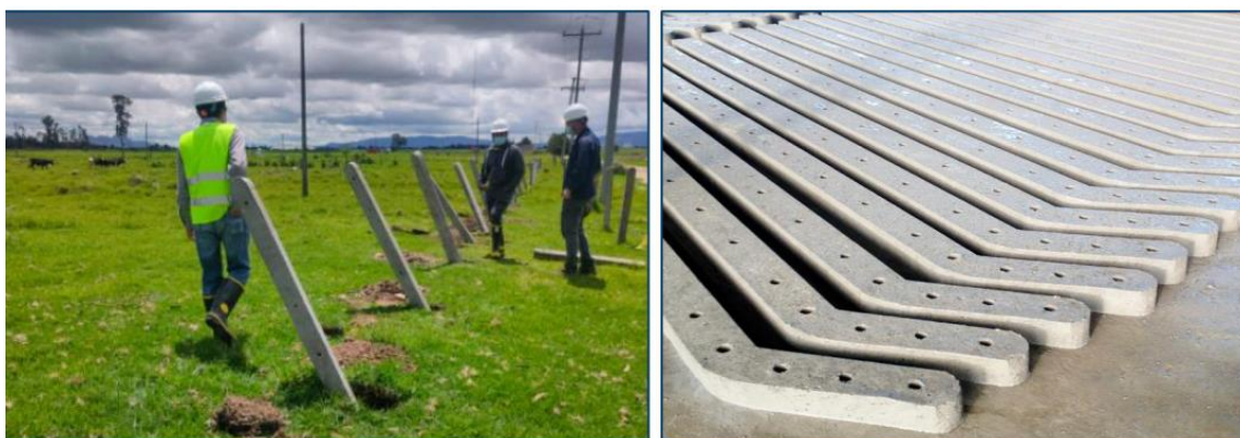
Fotografía 4 Conformación del cerramiento de seguridad perimetral en el Patio Taller
