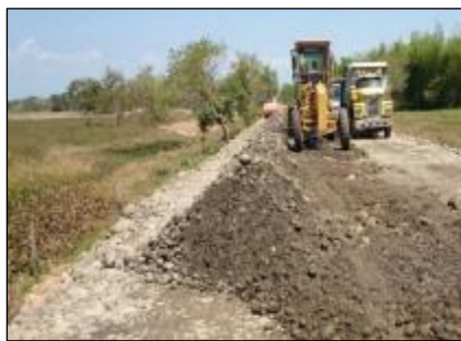
Fotografía 7 Escarificación de vía
