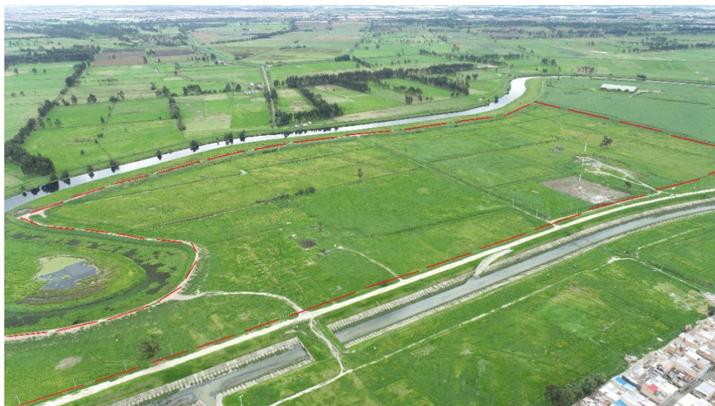
Fotografía 1 Estado actual predio del Patio Taller
