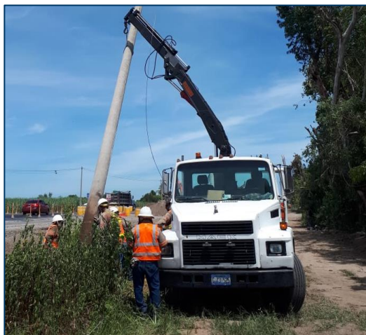
Fotografía 6 Traslado de postes eléctricos
