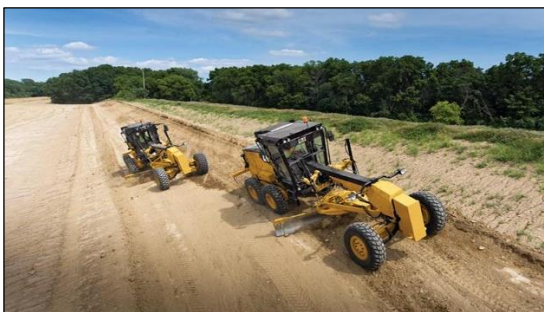
Fotografía 7 Escarificación de vía
