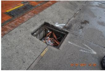
**Figura No. 59** Inexistencia de tapas de cajas de inspección
