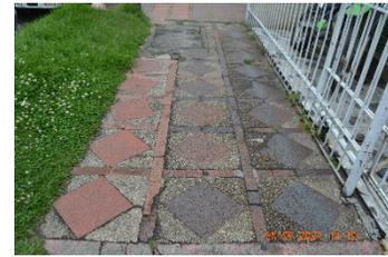
**Figura No. 74 Fisuras y desportillamientos**
