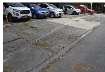
**Figura No. 30 Fisuras y biocapas en losa**
