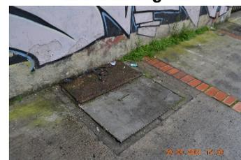
**Figura No. 58 Corrosión en tapa**
