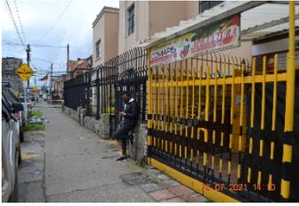
**Figura No. 69 Fisuras sobre andén, no hay bordillo**
