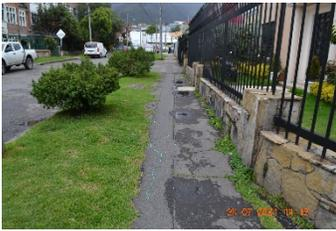
**Figura No. 72 Deformaciones y fisuras en andén**
