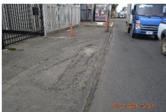
**Figura No. 50 Inexistencia de bordillo**
