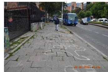
**Figura No. 17 Biocapas sobre juntas**
