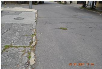
**Figura No. 25 Fisuras longitudinales y transversales cra 13**
