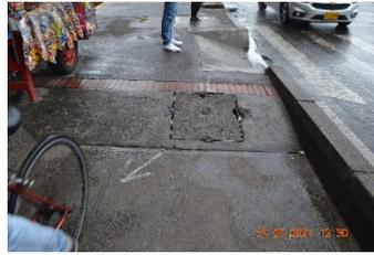
**Figura No. 60** Desportillamiento en tapas de cajas de inspección
