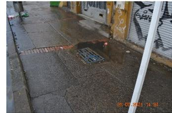
**Figura No. 77 Fisuras y agregado grueso expuesto**
