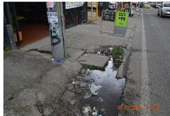
**Figura No. 48 Desprendimiento de material**
