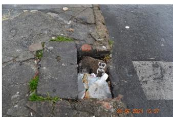
**Figura No. 56 Falta de tapas en cajas**
