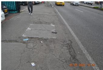
**Figura No. 47 Grietas sobre losa**
