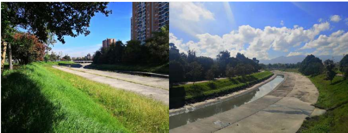
Figura 3.20 Registro fotográfico canal Rio Negro
