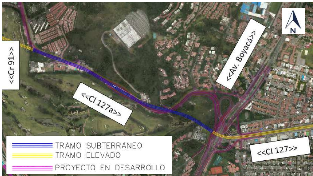
Figura 3.23 Tramo subterráneo posterior a la intersección CI 127 x Av. Boyacá
