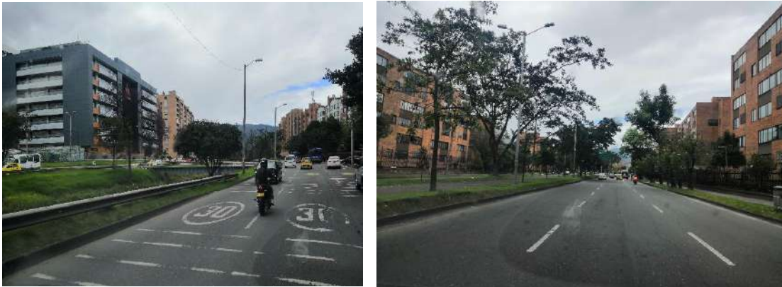
Figura 3.16 Registro fotográfico CI 127
