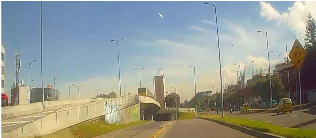
Figura 3.6 Afectación al monumento a los Héroes
