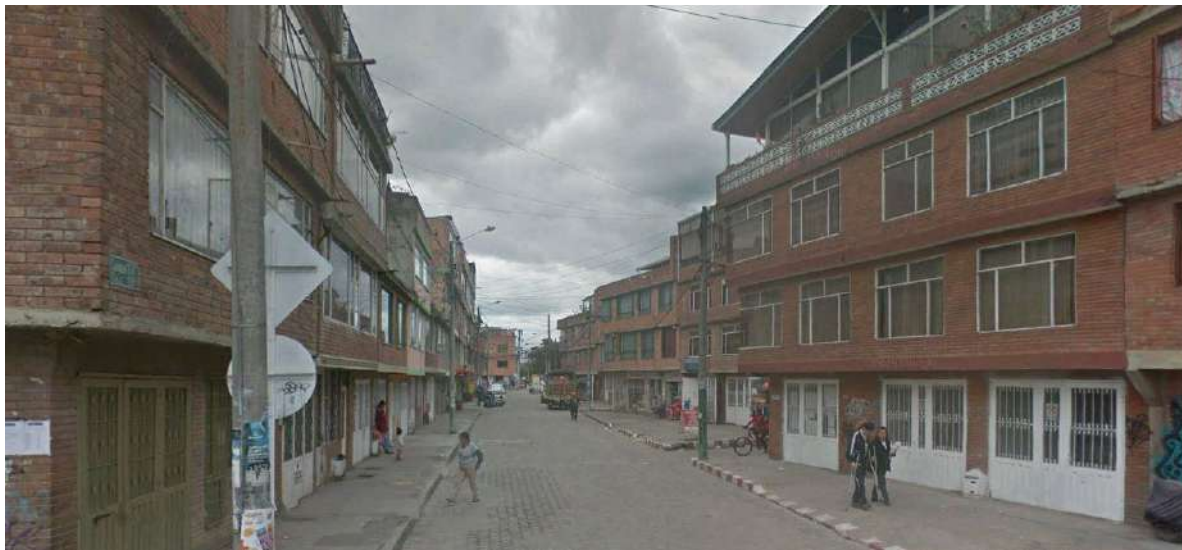
Fuente: Google Earth – Street View, 2019
