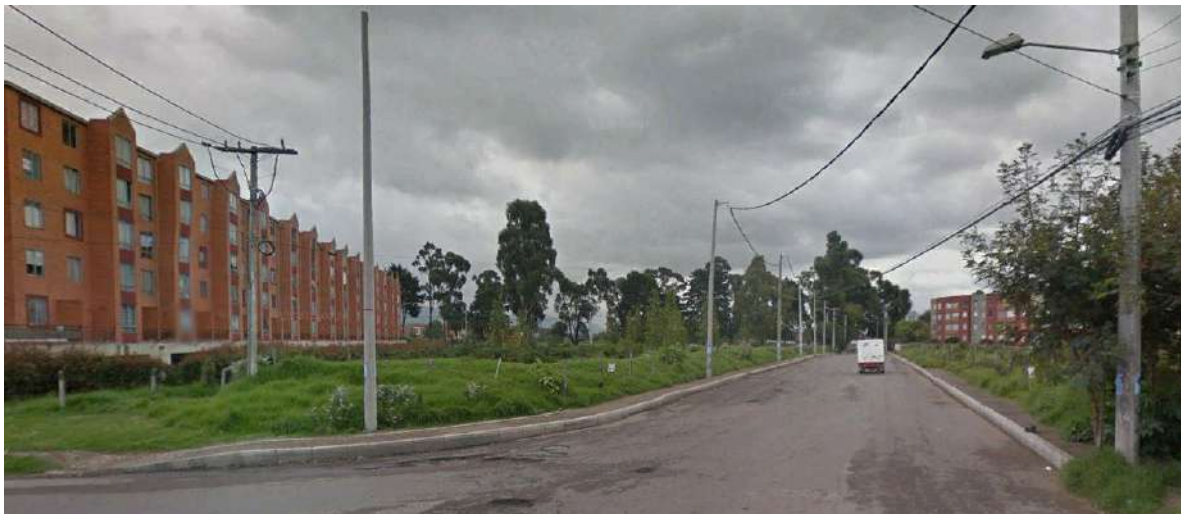
Fuente: Google Earth – Street View, 2019
