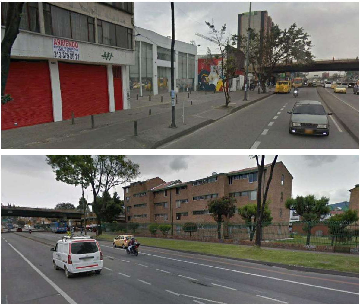
Figura 4.35 Estado actual sector Estación 4
