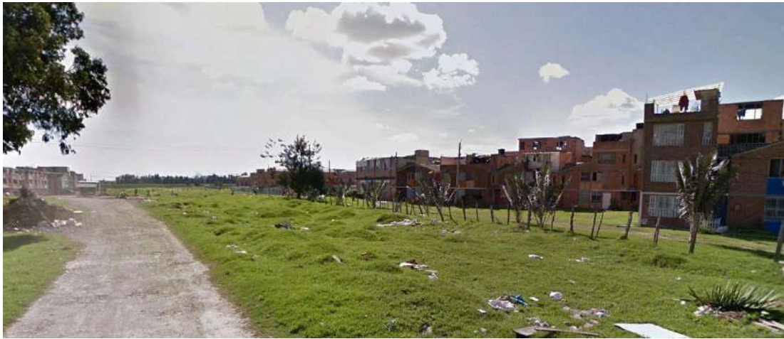
Figura 4.56 Estado actual sector Estación 11
