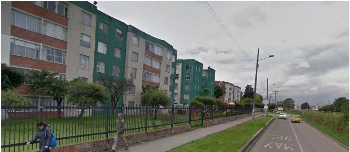
Figura 4.53 Estado actual sector Estación 10
