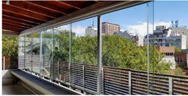
Figura 29. Cerramiento de vidrio templado Fuente: Tomada de www.google.com
