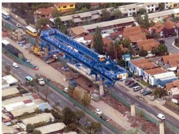
Ilustración 45 - Avance de la viga lanzadora a vano siguiente
