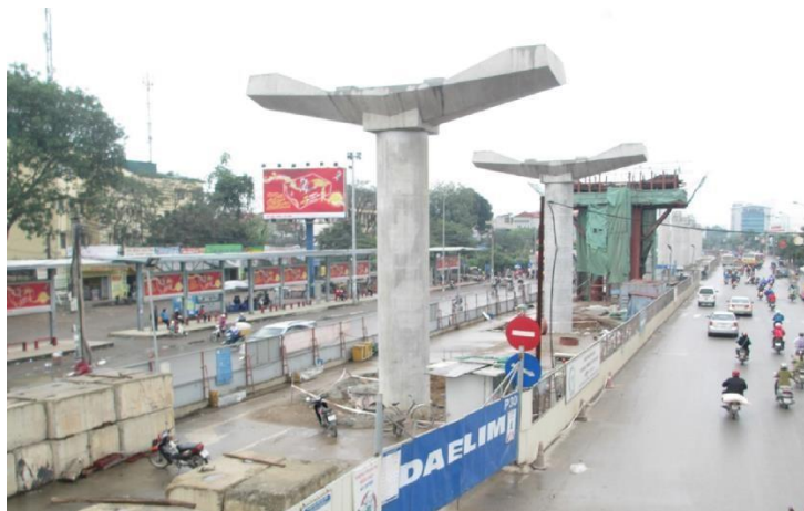
Ilustración 17 - Perímetro de obra para construcción de pilas (metro de Hanói)
