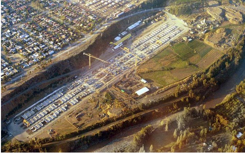
Ilustración 30 - Vista aérea de parque de prefabricación para L4 de Metro de Santiago de Chile
