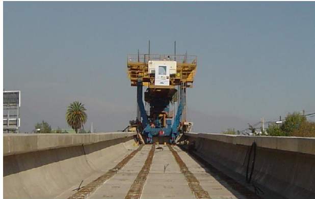
Ilustración 44 - Carro de apoyo de la viga lanzadora y sistema de avance sobre tablero
