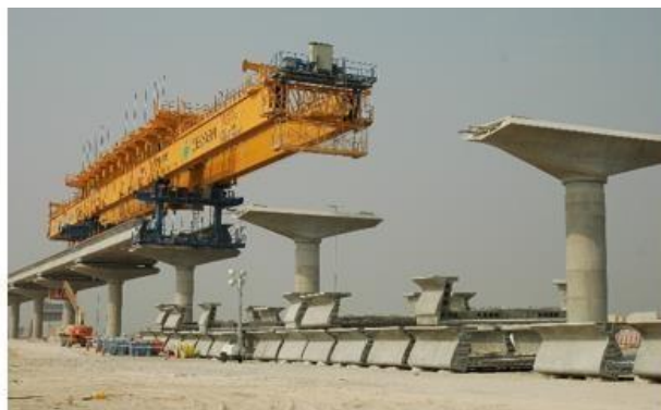
Ilustración 34 - Acopio de dovelas bajo viaducto
