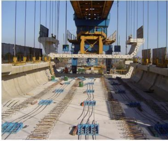
Ilustración 43 - Ensamblaje temporal de dovelas mediante barras de pre esforzado y aplicación de adhesivo epóxico
