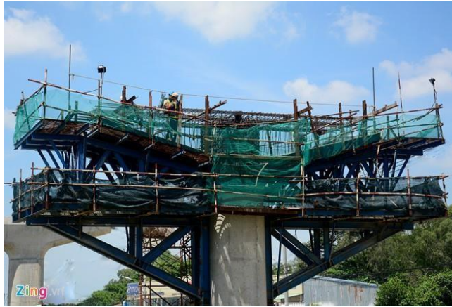
Ilustración 15 - Capitel colado in situ sobre cimbra soportada por brackets (metro de Ho Chi Minh)
