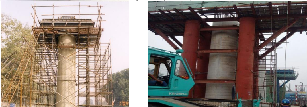
Ilustración 14 - Construcción de capitel colado in situ sobre cimbra apoyada en el suelo
