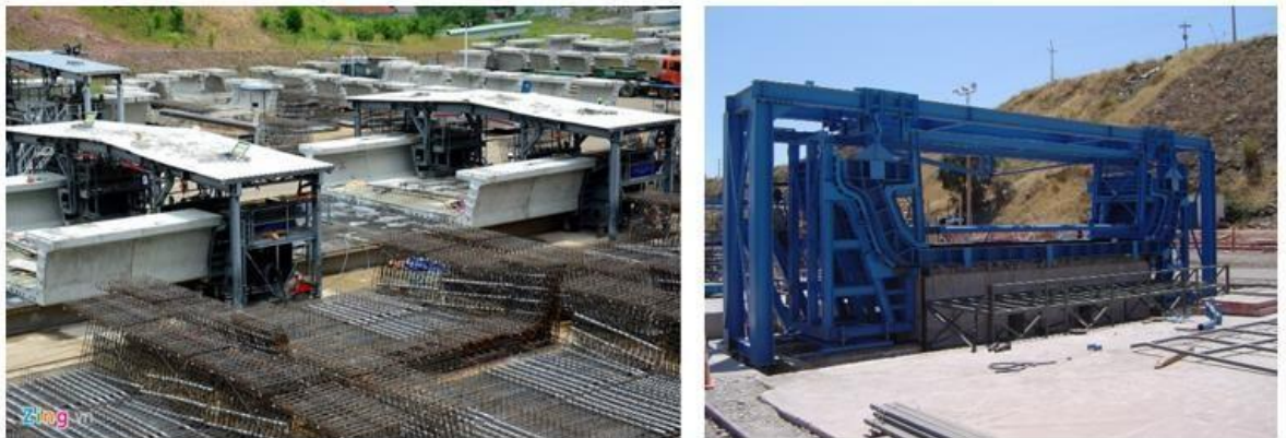
Ilustración 26 - Banco corto y molde para dovela de pila
