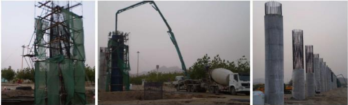
Ilustración 13 - Construcción de fustes de pila para viaducto de metro
