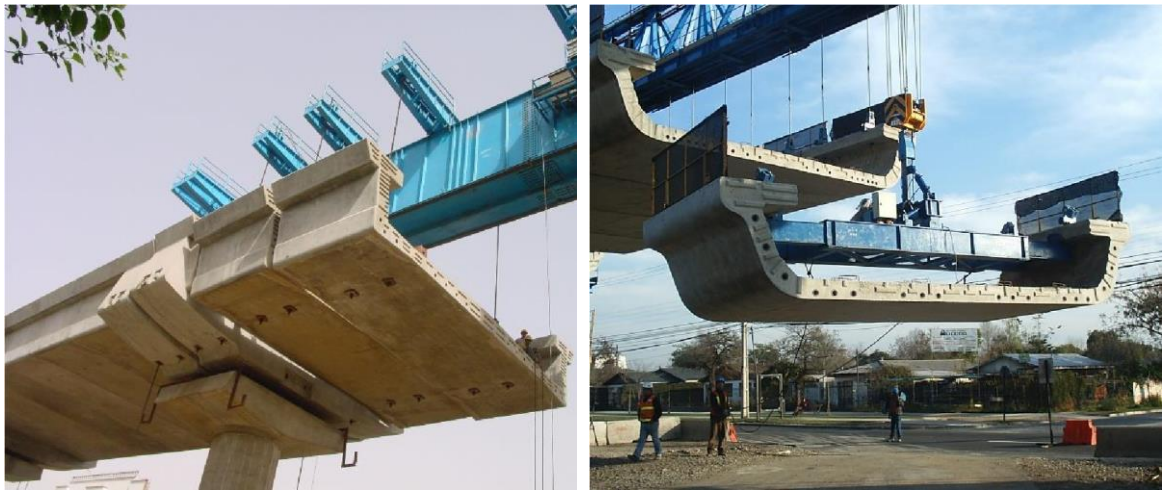
Ilustración 42 - Izado de dovelas mediante viga lanzadora
