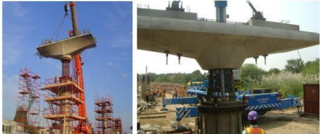
Ilustración 18 - Instalación de capitel prefabricado sobre anillo de posicionamiento
