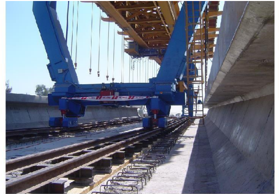
Ilustración 43 - Ensamblaje temporal de dovelas mediante barras de pre esforzado y aplicación de adhesivo epóxico
