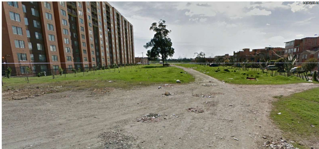
Fotografía 1. Vista General Alineamiento Calle 145
