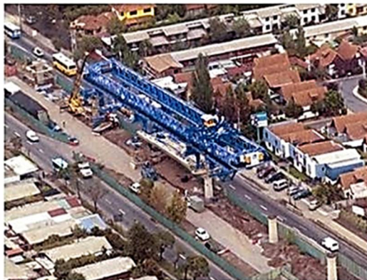
Figura 299. Avance de la viga lanzadora a vano siguiente
