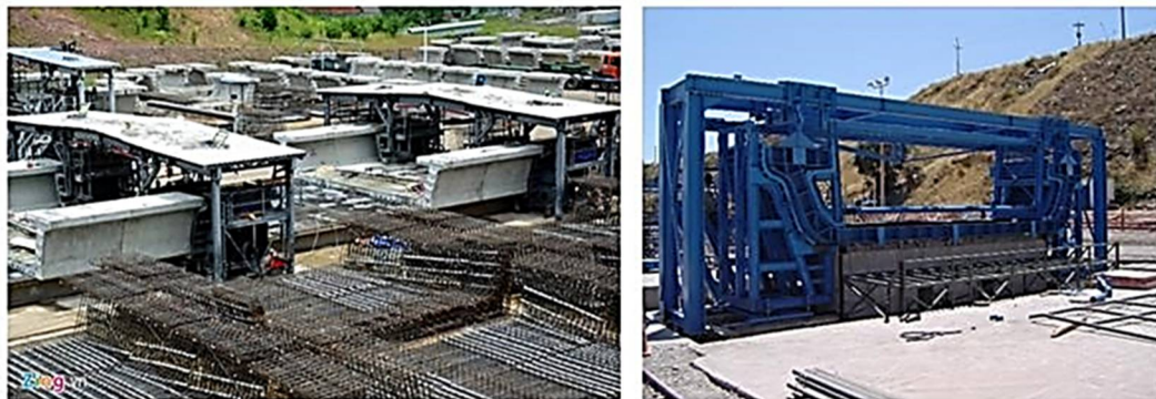
Figura 281. Banco corto y molde para dovela de pila
