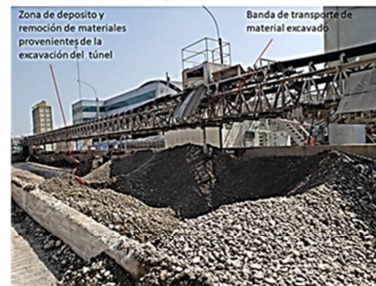
d. Zona de depósito de llegada de material del túnel – Banda transportadora
