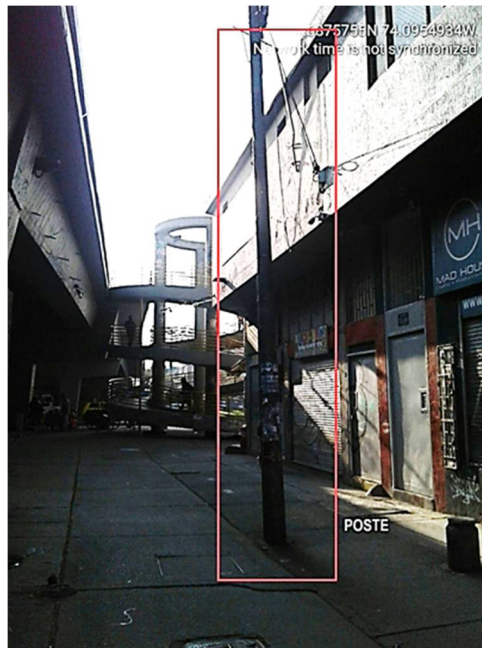
Fotografía 17. Redes de MOVISTAR en la estación Av. Boyacá. Fuente: UT MOVIUS 2022
