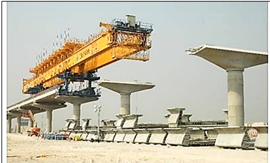
Figura 288. Acopio de dovelas bajo viaducto Fuente: UT MOVIOUS 2022
