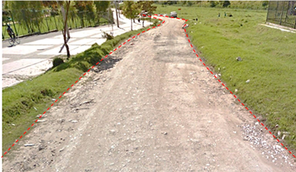
Fotografía 3. Situación actual calle 146 en cercanías del patio-taller Fuente: UT MOVIOUS 2022
