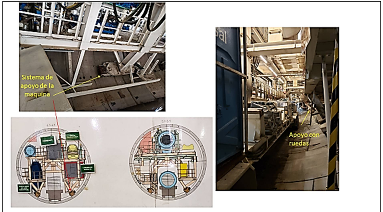
Fotografía 20. Sistema de apoyo de la máquina EPB sobre las dovelas con ruedas Fuente: UT MOVIUS 2022
