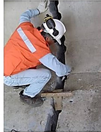
Figura 297. Ensamblaje temporal de dovelas mediante barras de pre esforzado y aplicación de adhesivo epóxico
