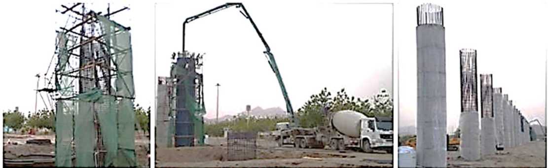
Figura 274. Construcción de fustes de pila para viaducto de metro Fuente: UT MOVIOUS 2022
