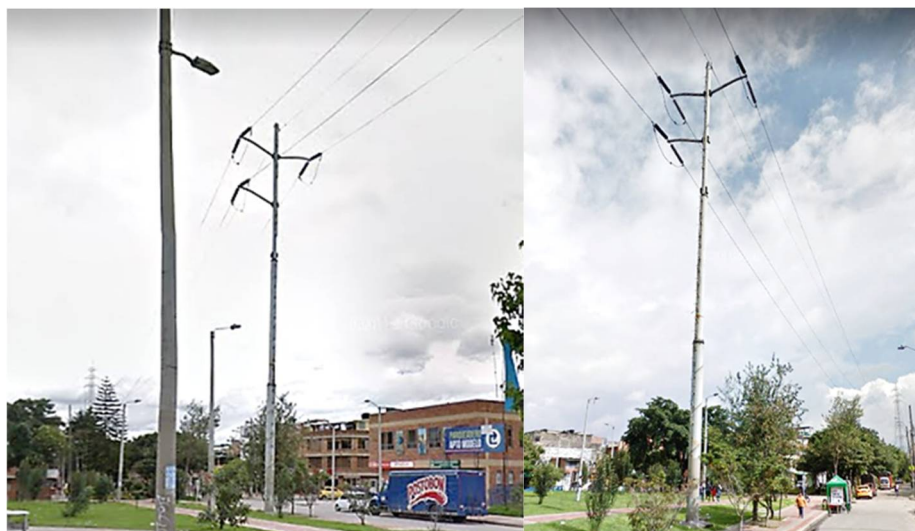
Fotografía 13. Red aérea de alta tensión - 115 kV - Cra 103 Fuente: UT MOVIUS 2022
