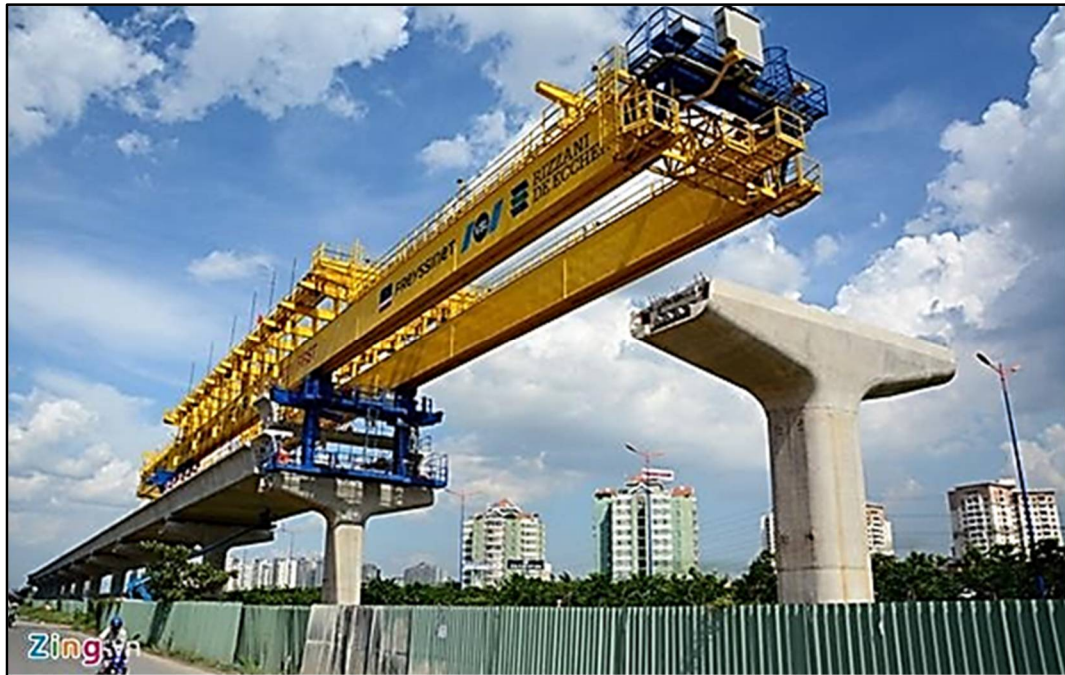
Figura 279. Montaje del tablero gran U del metro de Ho Chi Minh mediante viga lanzadora Fuente: UT MOVIUS 2022
