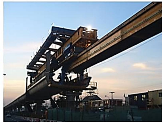
Figura 299. Avance de la viga lanzadora a vano siguiente
