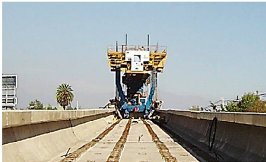
Figura 298. Carro de apoyo de la viga lanzadora y sistema de avance sobre tablero
