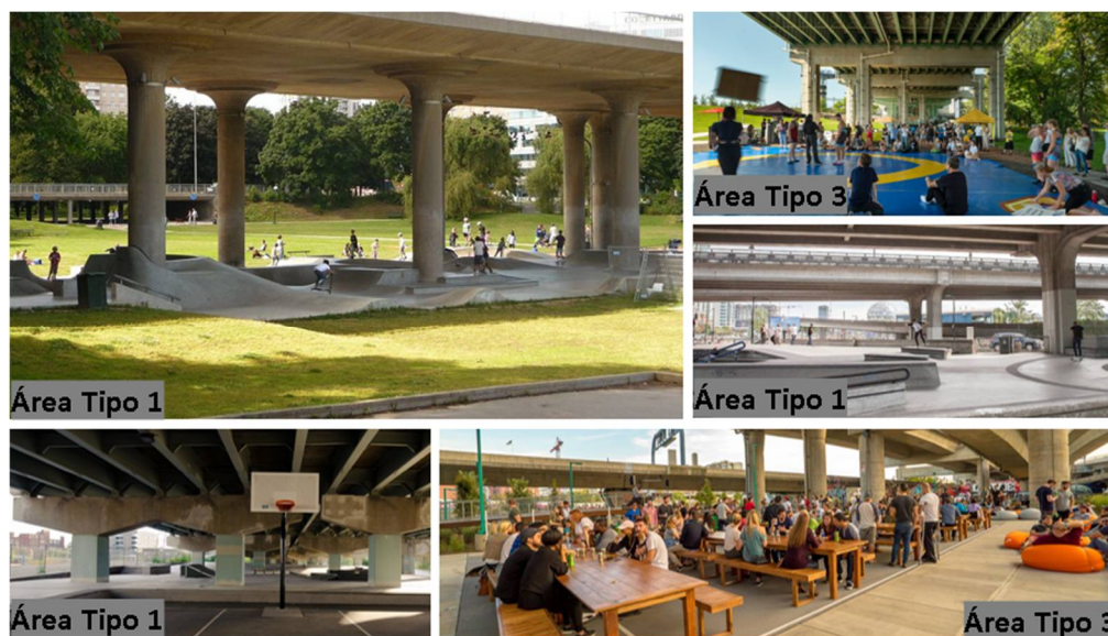
Figura 166. Actividades bajo viaducto parte 1 Fuente: Tomada y adaptada Google Maps
