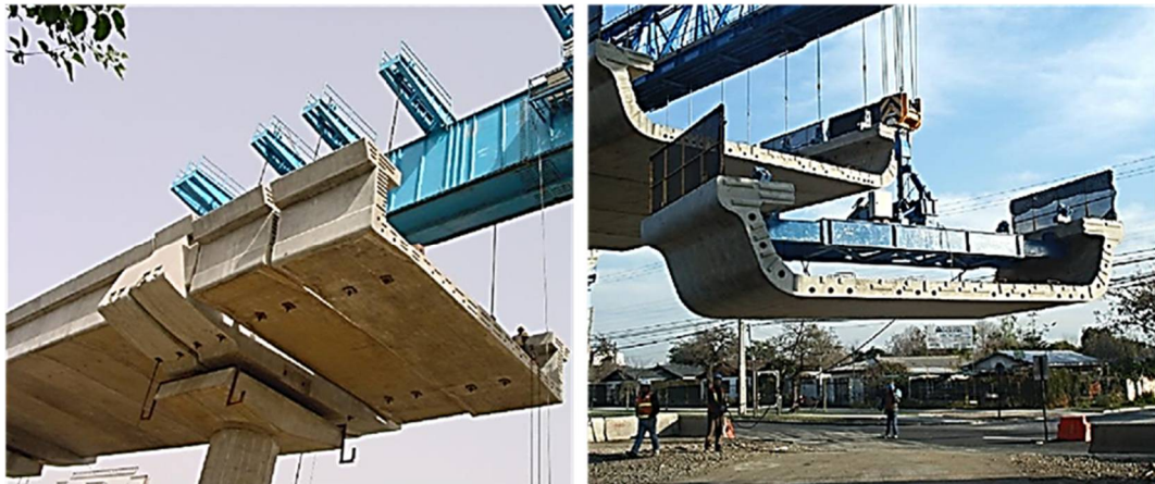
Figura 296. Izado de dovelas mediante viga lanzadora Fuente: UT MOVIUS 2022
