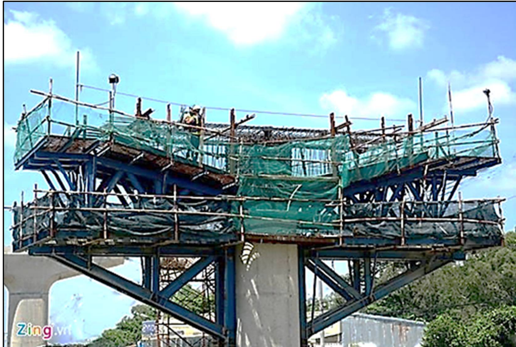
Figura 276. Capitel colado in situ sobre cimbra soportada por brackets (metro de Ho Chi Minh) Fuente: UT MOVIOUS 2022
