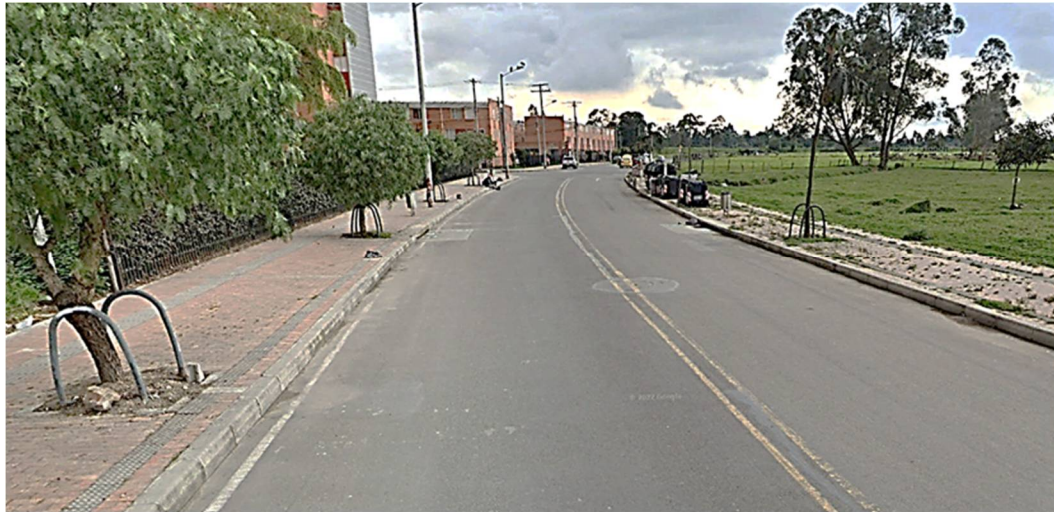
Fotografía 6. Situación actual diagonal 151 Fuente: UT MOVIUS 2022
