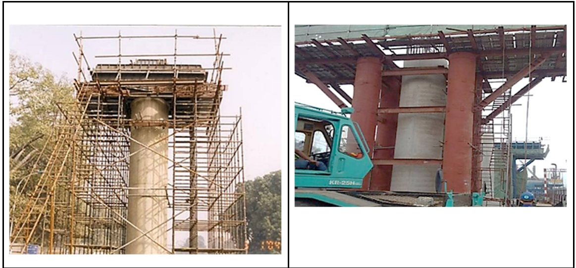
Figura 275. Construcción de capitel colado in situ sobre cimbra apoyada en el suelo Fuente: UT MOVIOUS 2022
