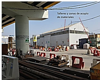
a. Talleres y zona de acopio
