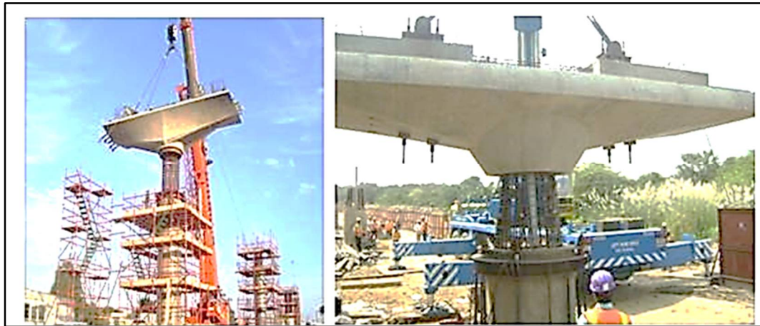
Figura 277. Instalación de capitel prefabricado sobre anillo de posicionamiento
