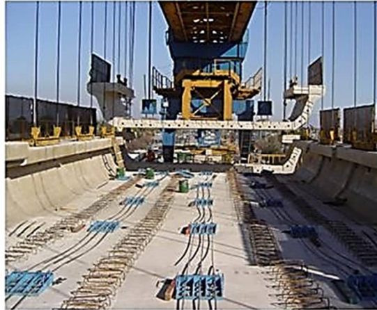
Figura 297. Ensamblaje temporal de dovelas mediante barras de pre esforzado y aplicación de adhesivo epóxico
