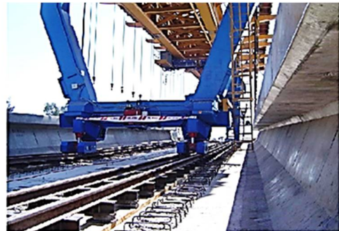
Figura 298. Carro de apoyo de la viga lanzadora y sistema de avance sobre tablero
