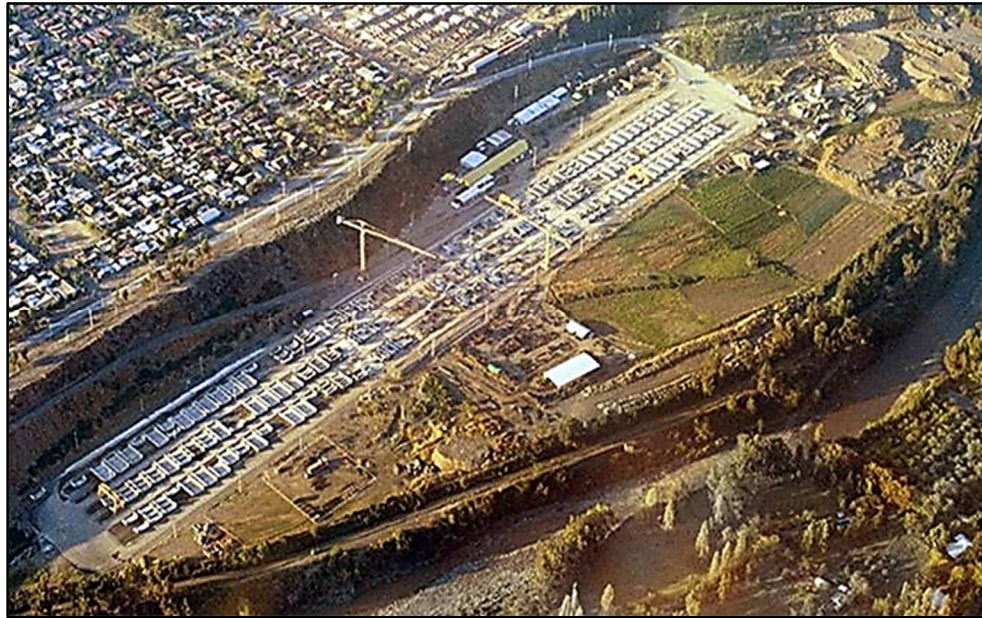
Figura 285. Vista aérea de parque de prefabricación para L4 de Metro de Santiago de Chile
