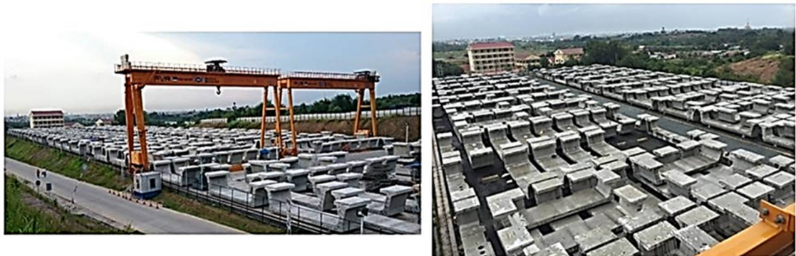
Figura 284. Áreas de acopio de dovelas en parques de prefabricación
