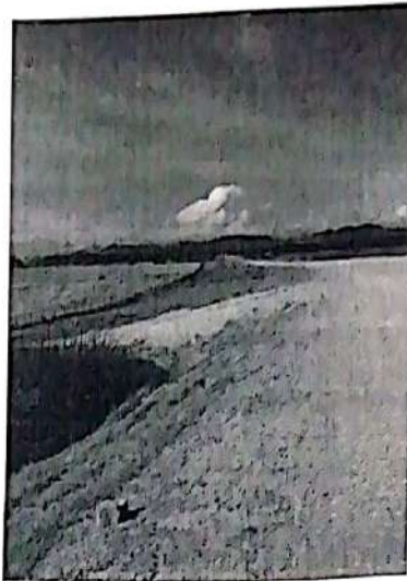
Foto 3 – Predio Recodo Nuevo Sur – cota baja e inundable -- fuente visita CAR
