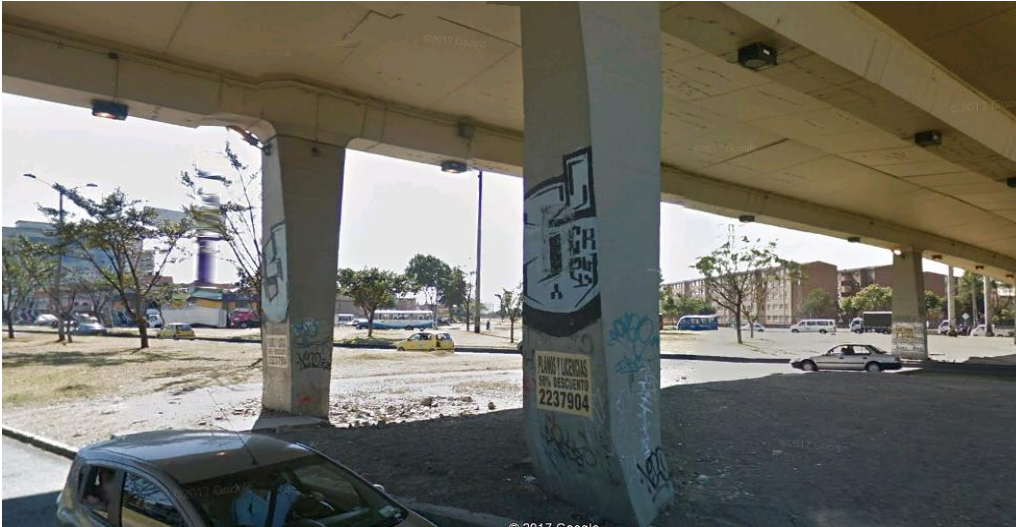
Puente Avenida 68 con 1 de mayo
