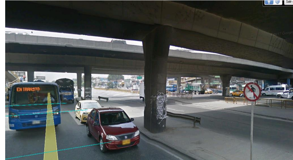
Puente Avenida Boyacá con 1 de mayo
