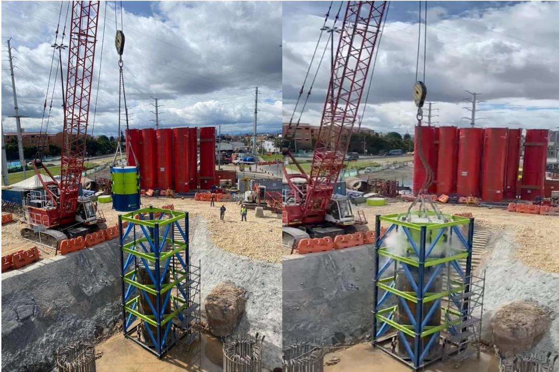
La prueba PDA, llamada así por sus siglas en inglés *Pile Driving Analyzer*, fue realizada en el pilote 12 del apoyo 4 del puente norte.
