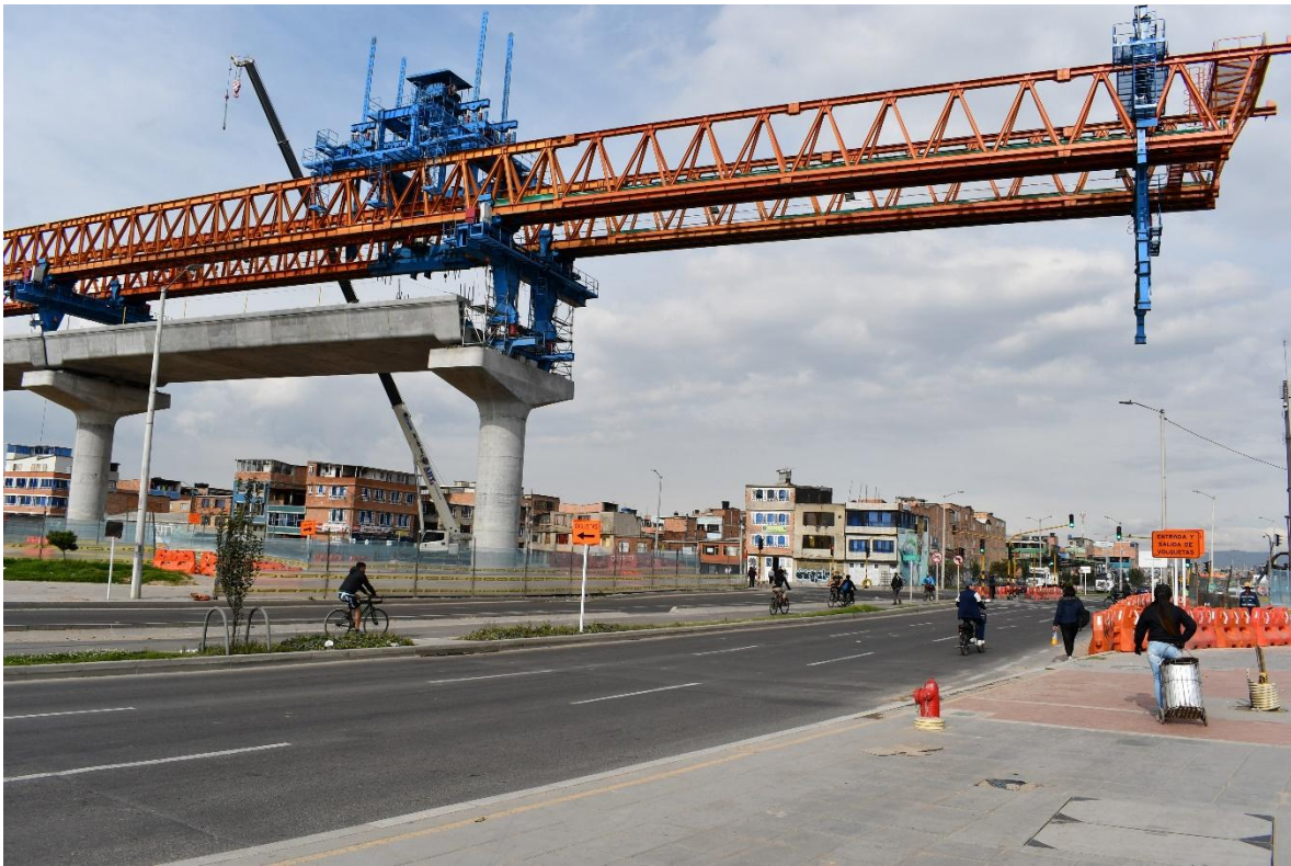
Viga Lanzadora, av. Villavicencio con av. Guayacanes
