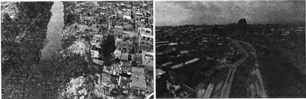
Fotografías 1 y 2. Sector El Porvenir Mosquera, antes y después de las actividades de intervención de la CAR. Fuente: CAR, (2017).
