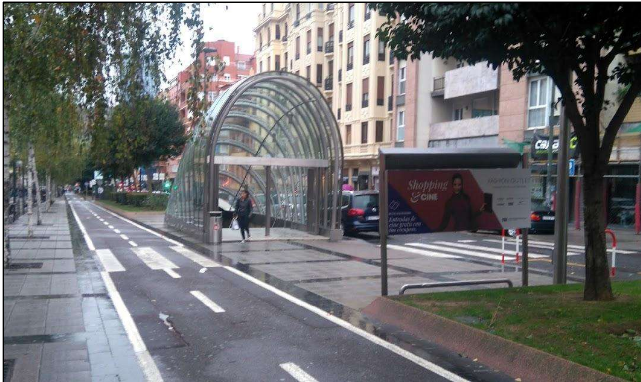
Figura 36. Línea 1-2. Estación Indautxu
