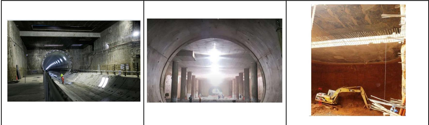
Figura 15. Estaciones construidas por el método Cut & Cover metros de Quito, Lima y Caracas.
