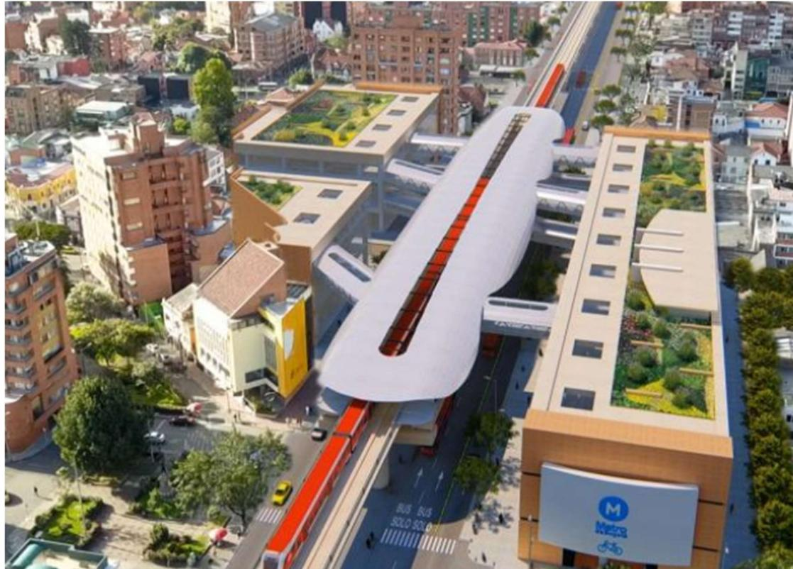
Figura 33. Vista aérea estación elevada con edificios de acceso a ambos costados
