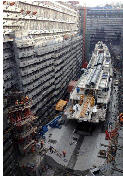
Fotografía 1. Tramo del Túnel Eurasia-Sistema “Cut&Cover” Fuente: https://www.wsp.com/en-CA/services/cut-and-cover-tunnelling
