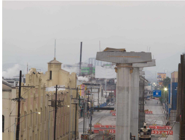
Fotografía 3. Construcción pilas viaducto. Línea 3 Metro de Monterrey. http://calledecadente.blogspot.com/2015/07/metro-linea-3-monterrey.html
