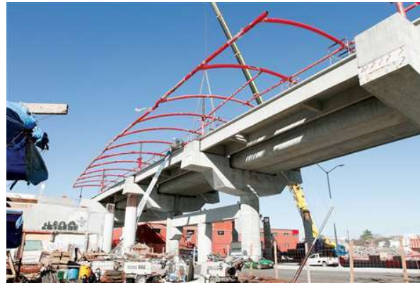
Fotografía 4. Avance en la construcción del viaducto. Línea 3 Metro de Monterrey. https://www.construccionlatinoamericana.com/news/linea-3-del-metro-monterrey-con-92-de-avance/4133513.article
