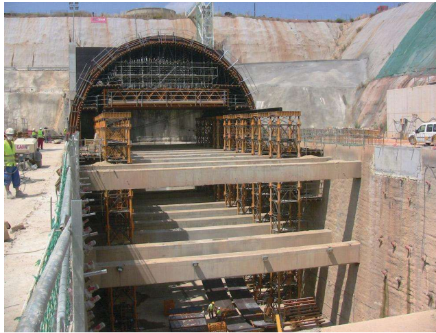
Fotografía 2. Tramo túnel en Terrasa-España-Sistema “Cut&Cover” https://www.ulmaconstruction.com/en/projects/tunnels/tunnel-extension-terrassa-spain
