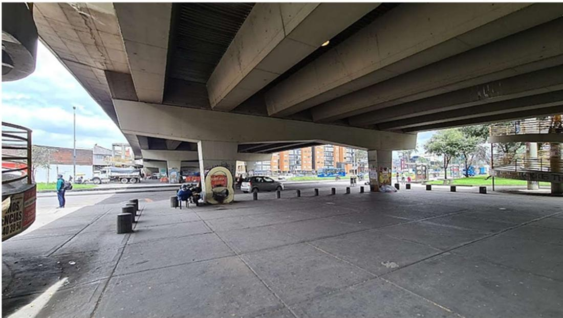
Fotografía 6. Vigas y pilas intermedias puente vehicular Av. Calle 72 con Av. Boyacá
