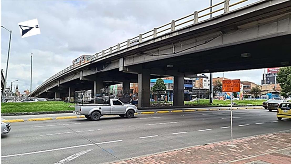
Fotografía 10. Vigas y pilas intermedias puente vehicular Av. Calle 72 con Av. Carrera 30 - Puente peatonal costado sur
