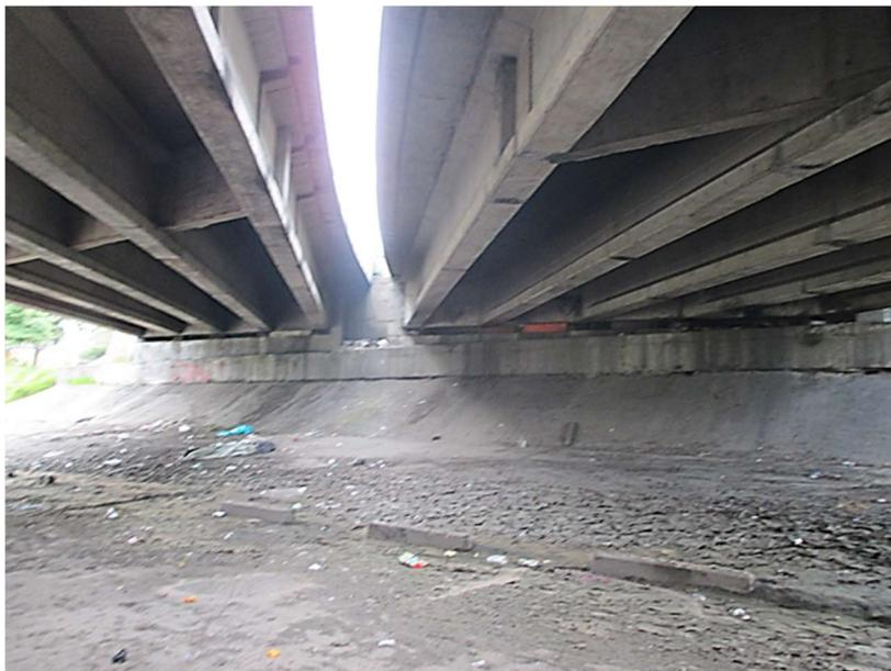
Fotografía 3. Vigas y riostras puentes vehiculares Av. Ciudad de Cali sobre canal Salitre
