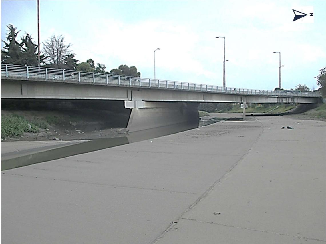
Fotografía 4. Pilas intermedias puentes vehiculares Av. Ciudad de Cali sobre canal Salitre
