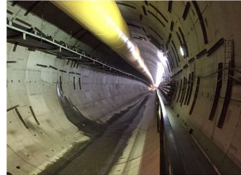
Tuneladora "La Guaraqua" avanza con la construcción del túnel.
