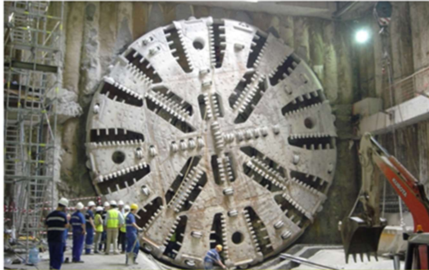
Figura 36. Maquina EPM utilizada en el Metro de Barcelona
