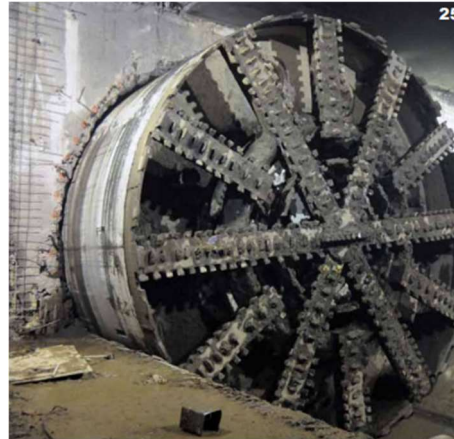
Figura 31. ICA. (2012). Infraestructura línea 12 del metro. Vector de la ingeniería civil. Ciudad de México, México.
