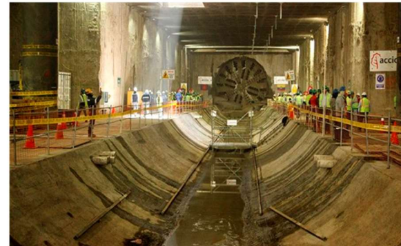
d. Detalle de paso de la máquina EPB
